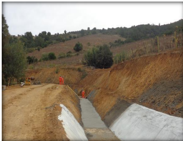
Hormigonado de canal, Km 12,750.
