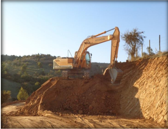
Preparación de plataforma, Km 33,800.
