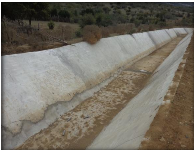
Hormigonado de canal, Km 10,340.
