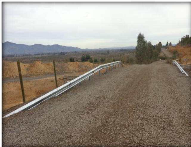
Defensa caminera en Obra de Arte N°4, Km 21,760.
