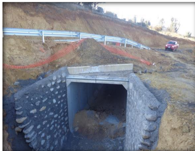
Mampostería en Obra de Arte N°1, Km 15,560.
