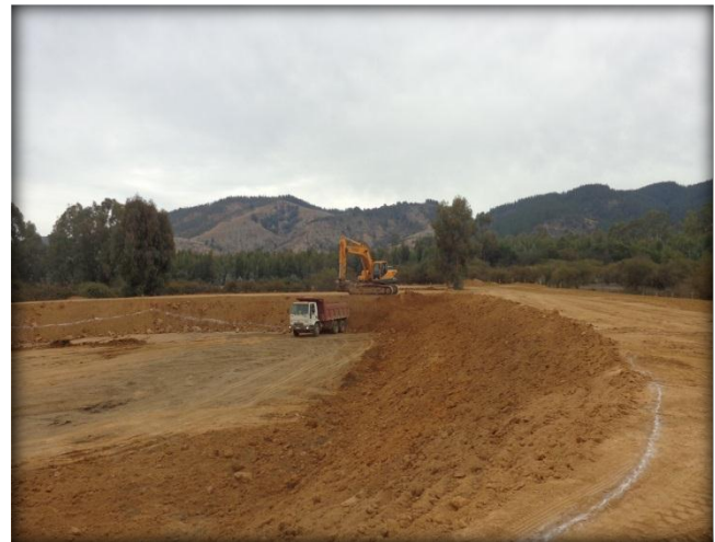
Corte en terreno y construcción de terraplenes, Km 27.700.
