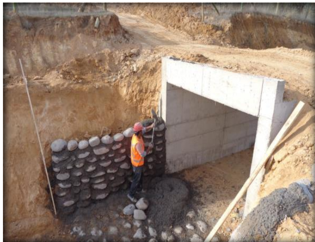
Mampostería para paso predial, Km 25,500.
