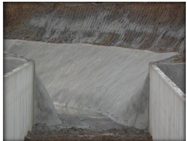
Hormigonado de canal, Km 0,560.
