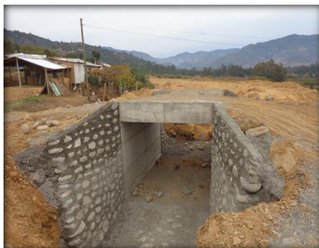
Mampostería en paso predial, Km 15,370.
