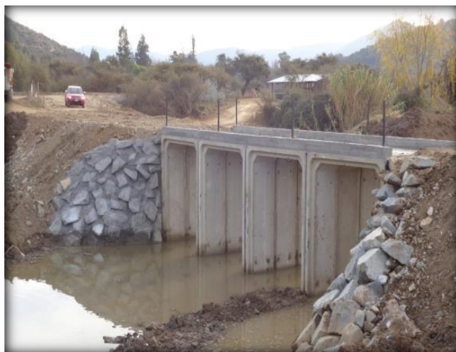
Vista cajones en Cruce Aspillaga.
