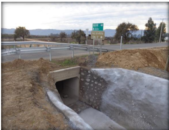
Hormigonado de canal, Km 11,170.
