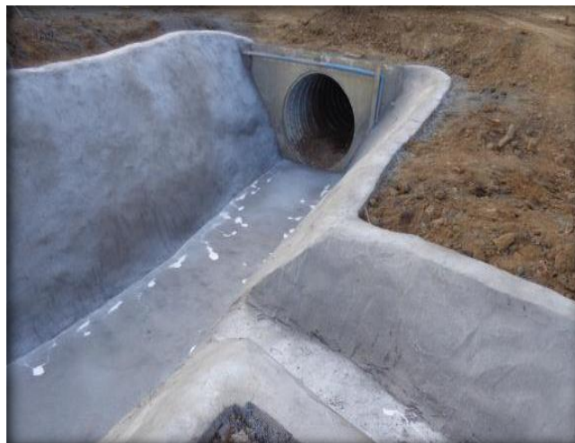
Hormigonado de canal, Km 13,480.
