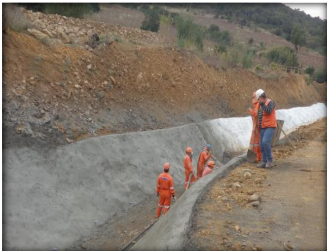
Hormigonado de canal, Km 12,860.
