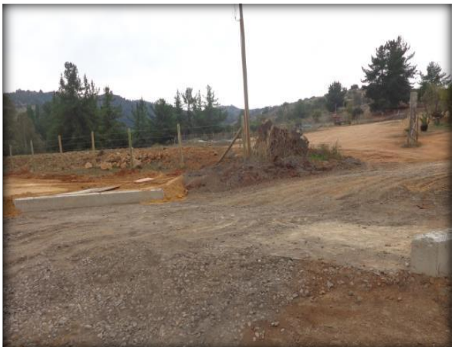
Obra de Arte N°2, Km 20,370.
