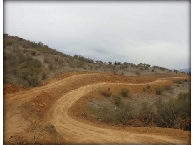
Movimiento de tierras, Km 36,760.
