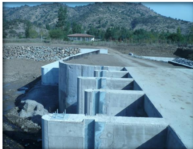
Bocatoma Canal Norte Unificado, barrera frontal.
