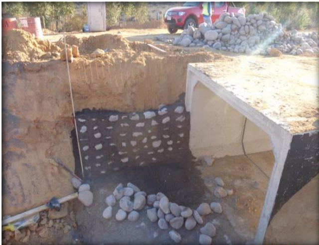
Mampostería para paso predial, Km 25,160.
