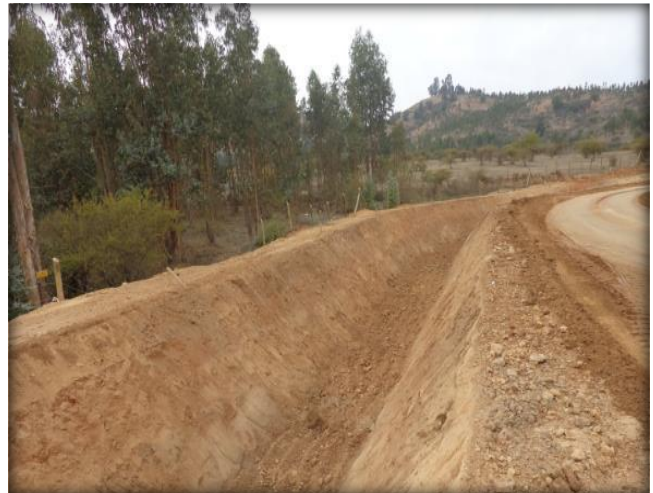
Corte de canal, Km 26,800.
