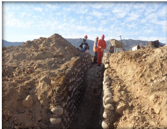
Mampostería para vertedero.
