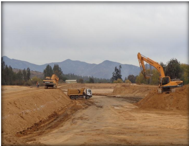
Corte en terreno y construcción de terraplenes, Km 27.700.
