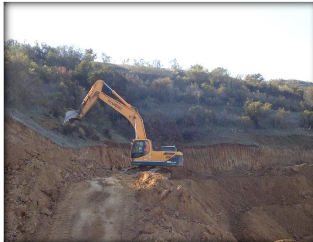
Corte en terreno, Km 34,900.
