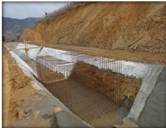
Armadura para paso predial, Km 12,960.
