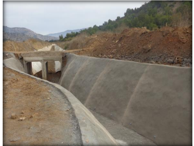
Hormigonado de canal, Km 0,580.
