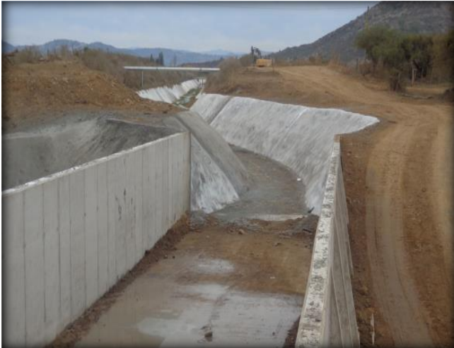
Hormigonado de canal, Km 0,500.
