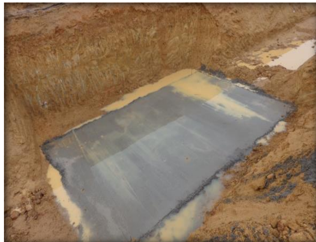
Emplantillado de paso predial, Km 26,140.
