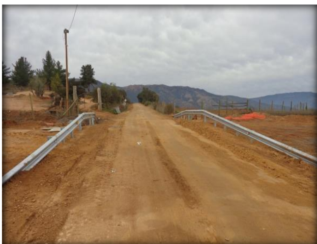
Defensa caminera en Obra de Arte N°2, Km 20,370.
