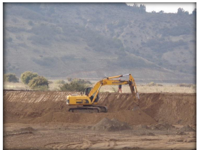
Corte talud, km 3,360
