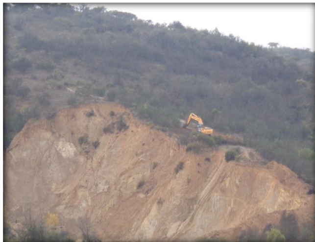
Movimiento de tierras, Km 37,700.
