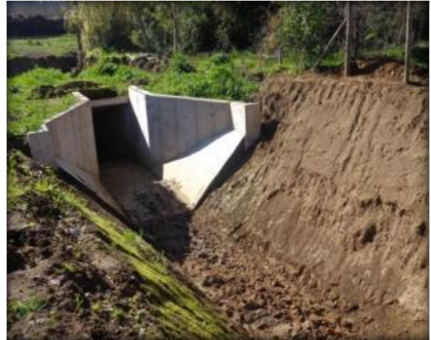
Cámara de salida de Sifón Fortaleza.
